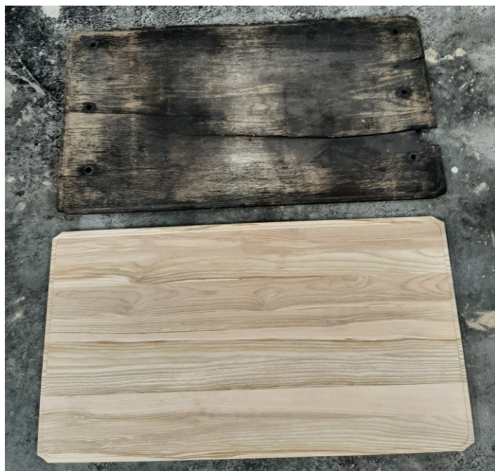
Wymiana uszkodzonej deski frontowej
