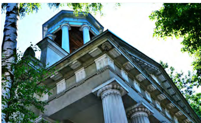
Widok na palmetę pod gzymsem, ul. Browna 30
