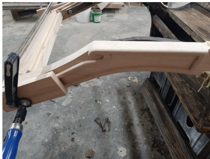
Wymiana zniszczonych elementów drewnianych
