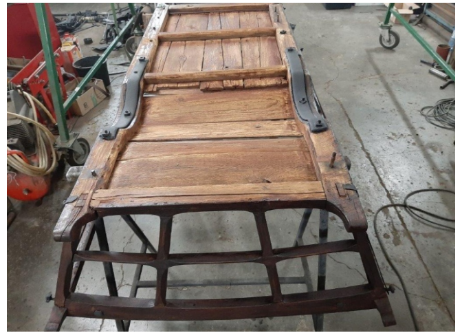
Malowanie elementów drewnianych
