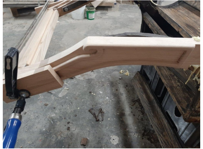
Wymiana zniszczonych elementów drewnianych
