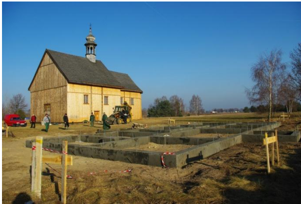
Konserwacja drewna i budowa fundamentów w listopadzie 2011
